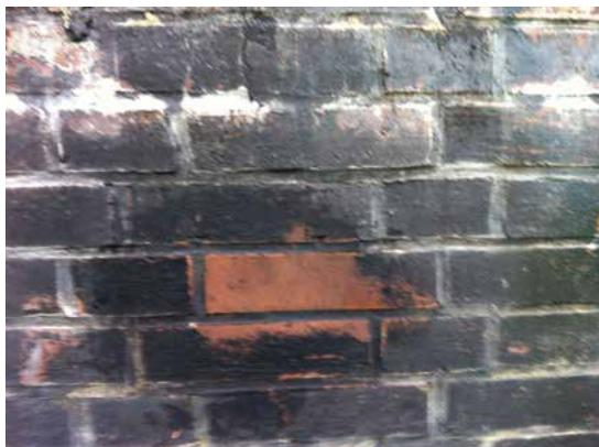
An dieser Fassade wird der Unterschied zwischen gereinigter und verschmutzter Fläche direkt sichtbar
